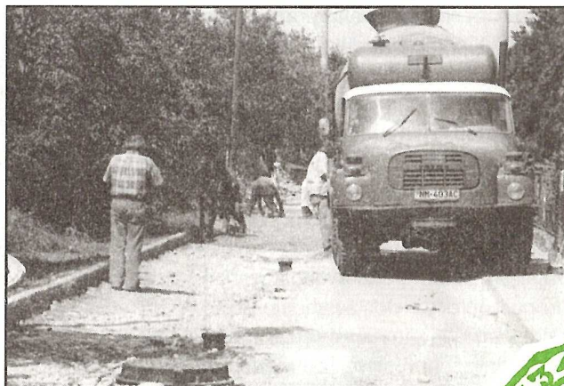
Budovanie kanalizácie v obci I. etapa
