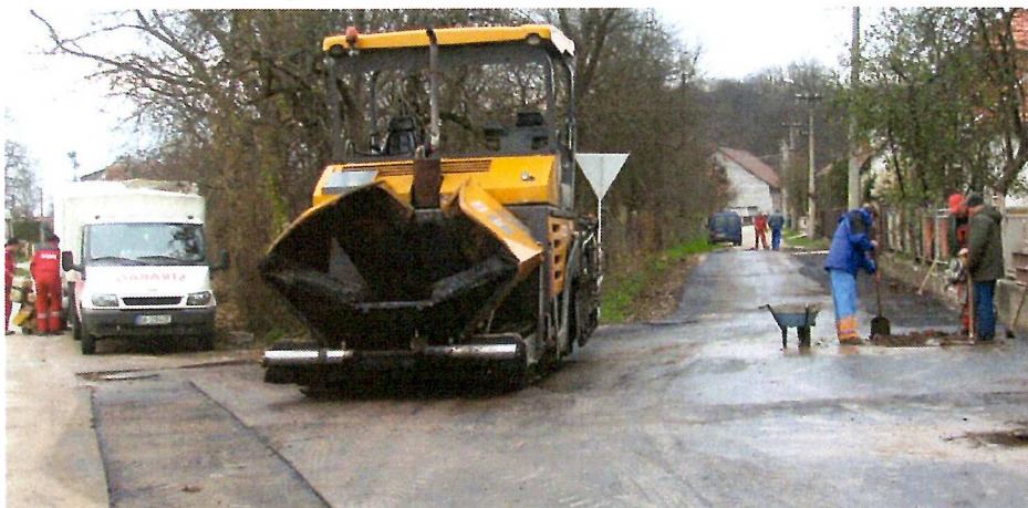
Asfaltovanie časti uličky Tehelná po položení rozvodov kanalizácie
