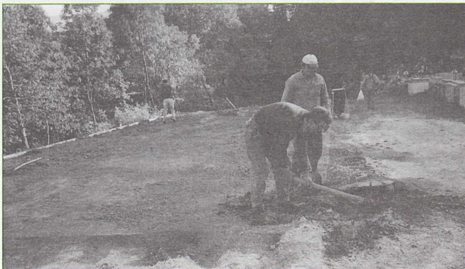
Práce na rozšírení a úprave cintorína.
